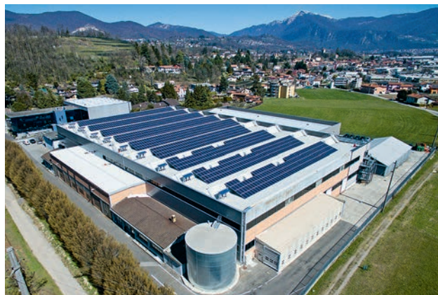
Messo in servizio nel 2015: l'impianto fotovoltaico naturemade star dell'Azienda Elettrica Ticinese e delle Aziende Municipalizzate di Stabio. (Foto: AET)
