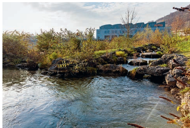
Canale di diversione delle acque della centrale Ruppoldingen di proprietà di Alpiq Hydro Aare AG. (Foto: Alessandro Della Bella)
