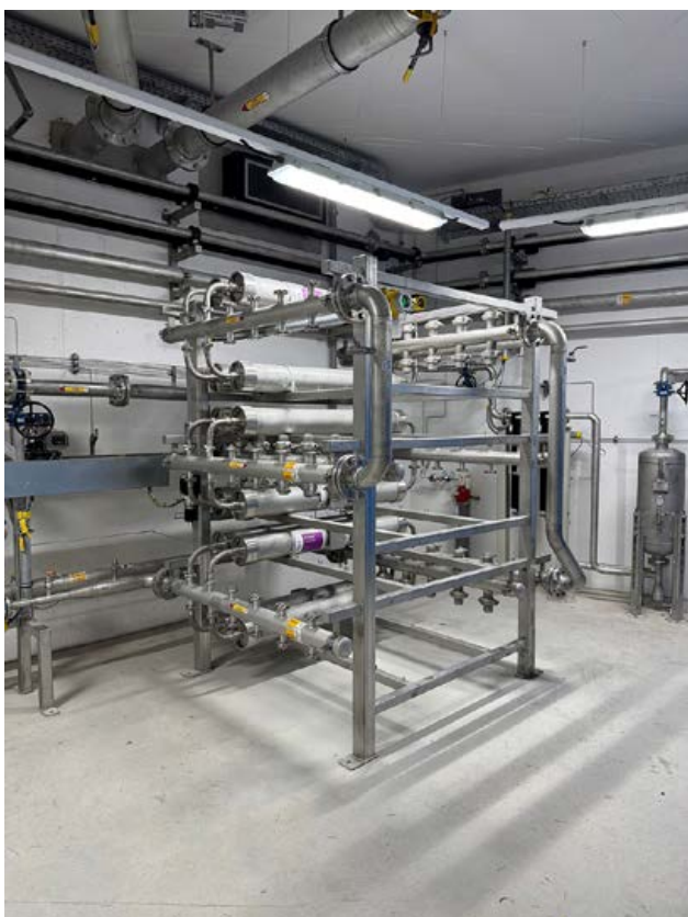
Impianto a membrane del nuovo impianto di biogas certificato naturemade star a Basilea (foto: ProRhenno)
