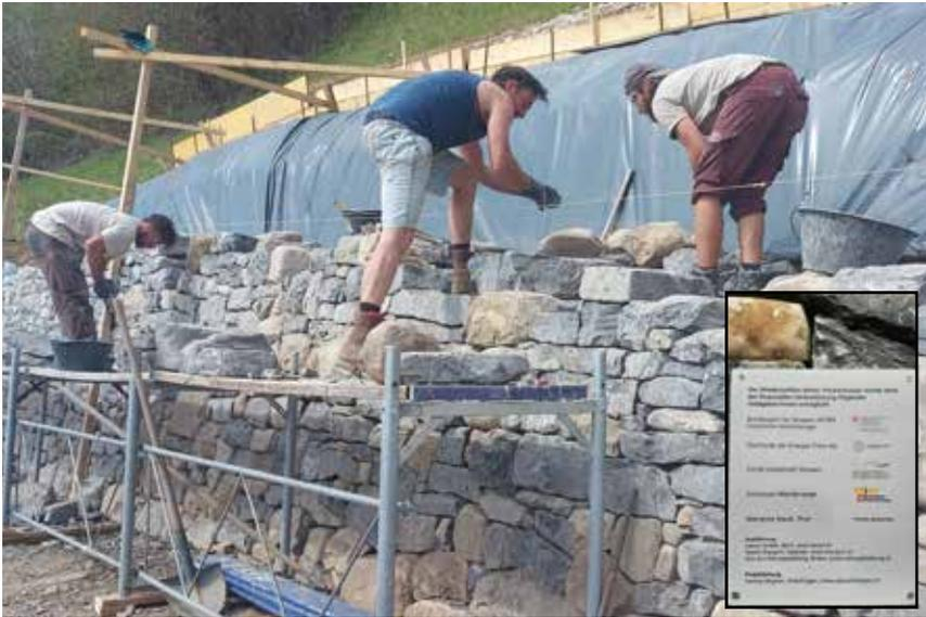
**Ersatz und Wiederaufbau Trockenmauer bei Merligen BE:** Die wieder aufgebaute Trockenmauer beim ehemaligen Rebgut Rälligen erstrahlt auf einer Länge von 25 Metern in neuer, stabiler Pracht. An dieser sonnenreichen Lage bietet sich ein attraktiver Lebensraum für Flora und Fauna. Orchideen- und Reptilienvorkommen, konkret das Vorkommen von Schlingnattern, sind im Gebiet dokumentiert. (Ökofonds der Energie Thun AG)
