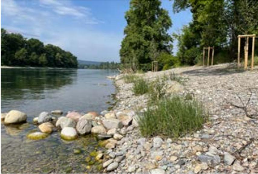
**Renaturierungsprojekt Rheinhalde West:** Im Gebiet «Rheinhalde West» bei Gallingen wurde eine 60 Meter lange Betonmauer abgebrochen und ein naturnahes Kiesflachufer erstellt. Das Ufer wurde mit Wurzelstöcken, Findlingen und dem Einbau von Bühnen zusätzlich strukturiert sowie mit Rohrglanzgras begrünt. (Fonds der KW Schaffhausen)
